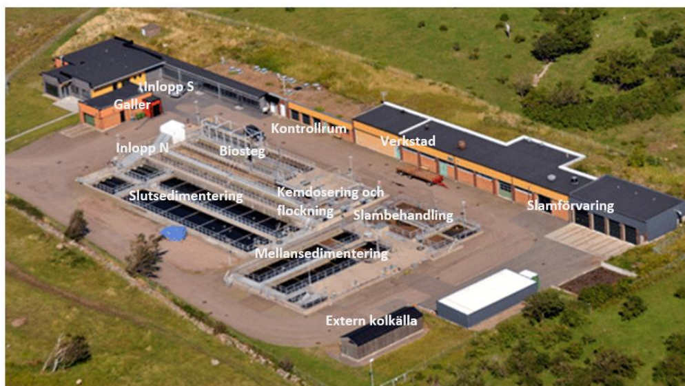
Figur 4. Foto över Torekov ARV och de olika processtegen.
