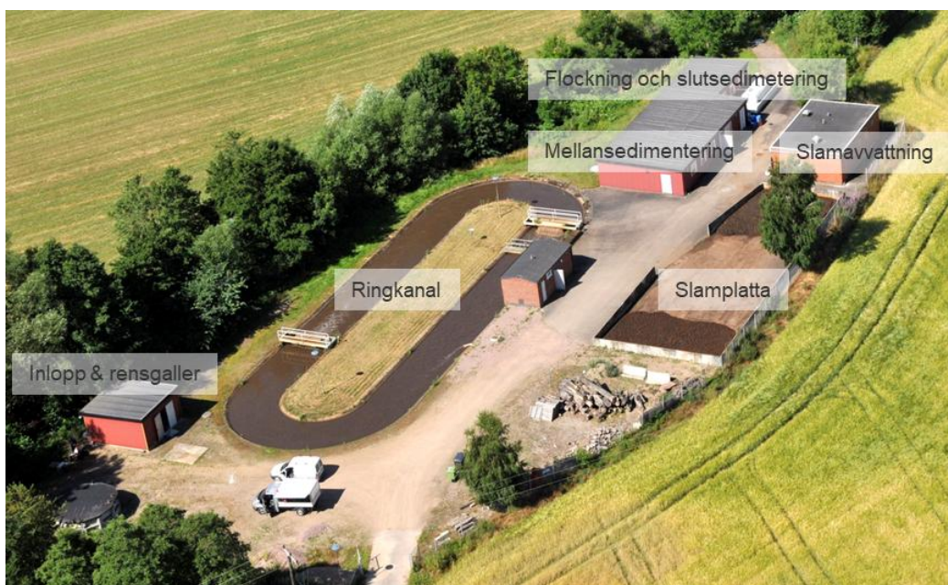
Figur 4. Flyg över Röstånga avloppsreningsverk och de olika anläggningsdelarna.
