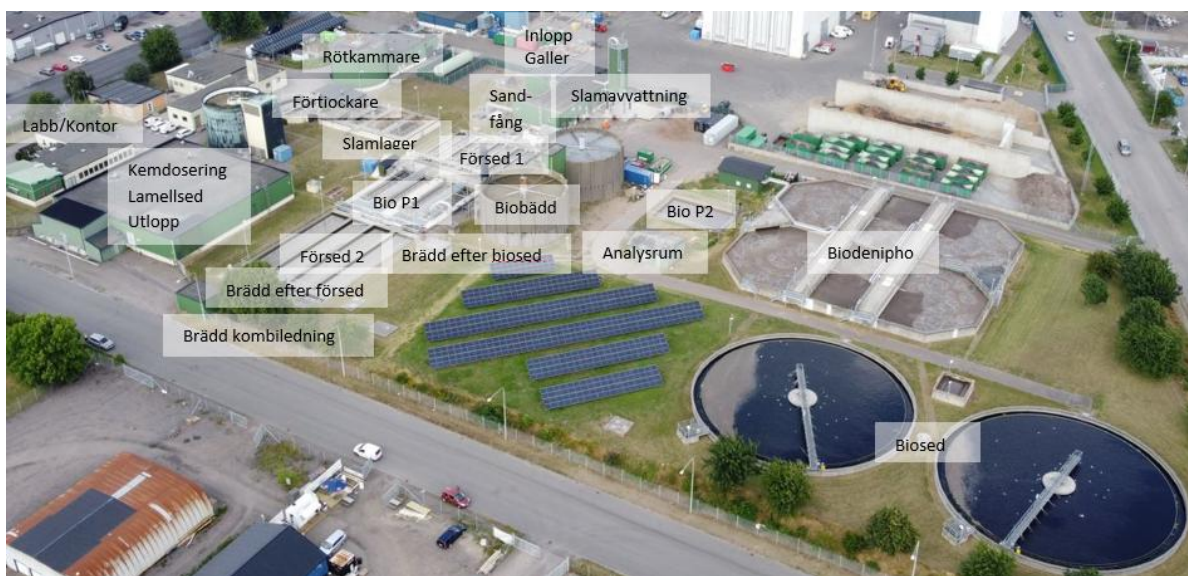
Figur 5. Foto över Lundåkraverket som presenterar de olika reningsstegen.
