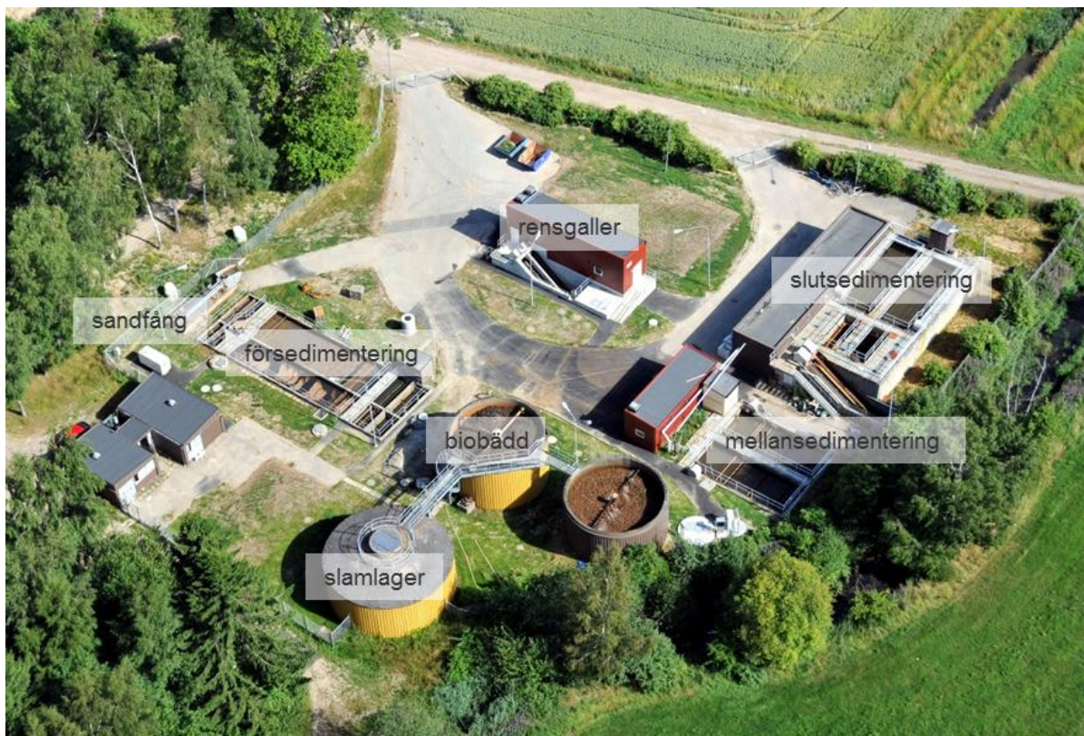
Figur 3. Flygfoto Ekeby avloppsreningsverk och de olika anläggningsdelarna.
