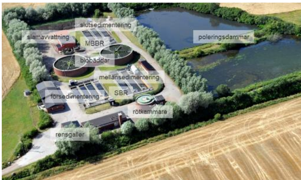
Figur 3. Flygfoto Ekebro avloppsreningsverk och de olika anläggningsdelarna
