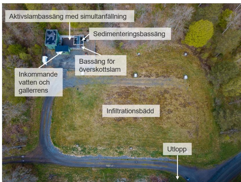
Figur 4. Foto över Oderljunga ARV och de olika anläggningsdelarna
