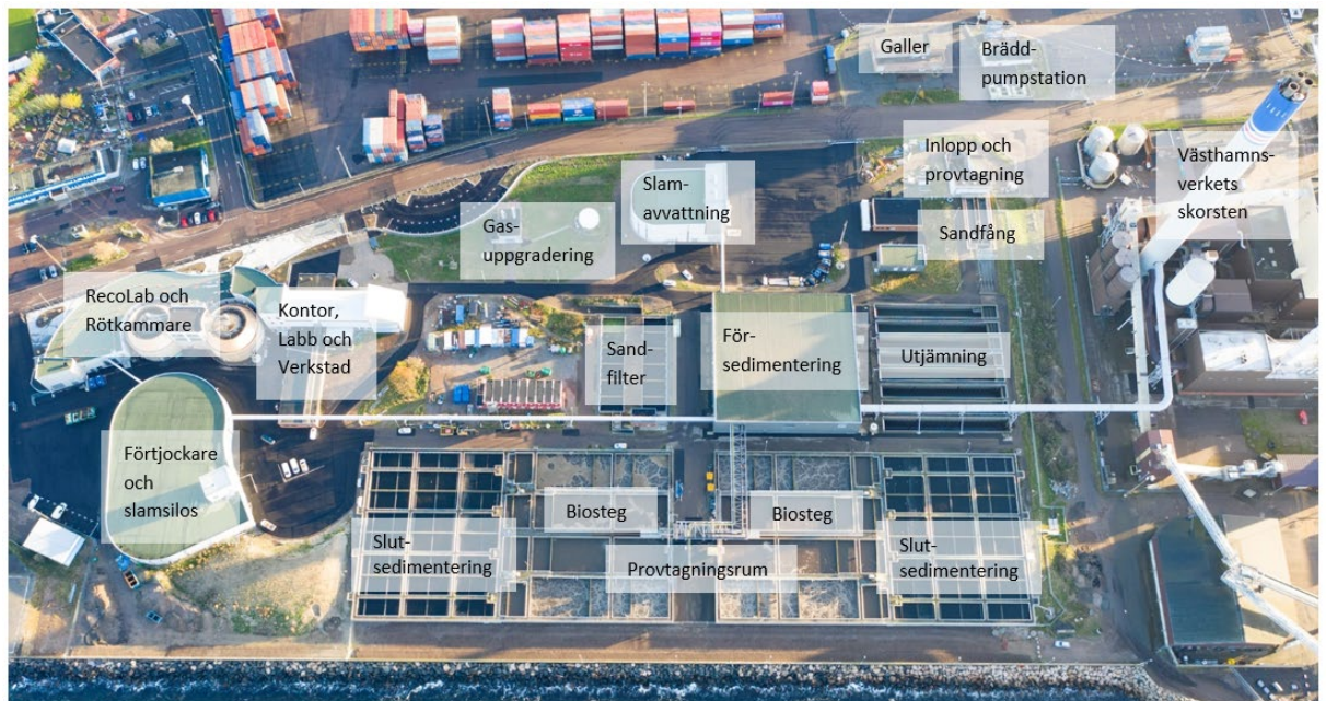
Figur 5. Foto över Öresundsverket och dess olika reningssteg.
