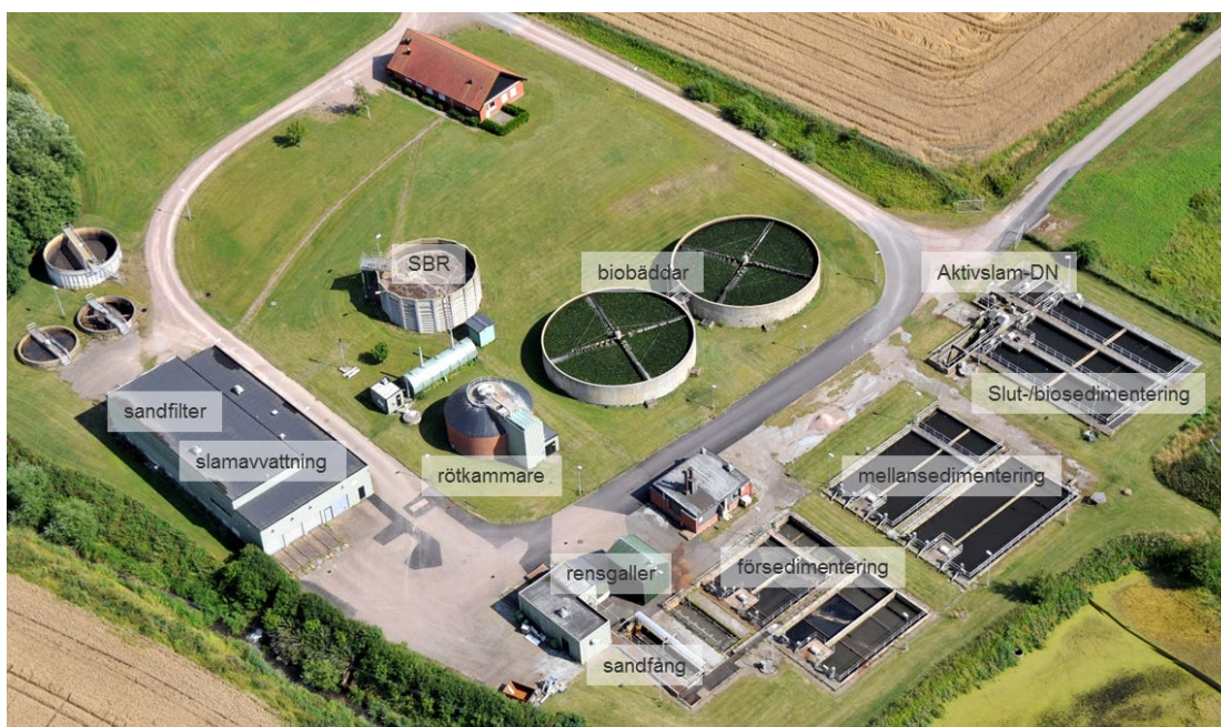
Figur 4. Foto över Nyvångsverket som presenterar de olika reningsstegen.
