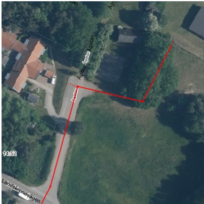
Figur 13. Del av spillvattenledning på Ågatan som renspolades i september 2024.
