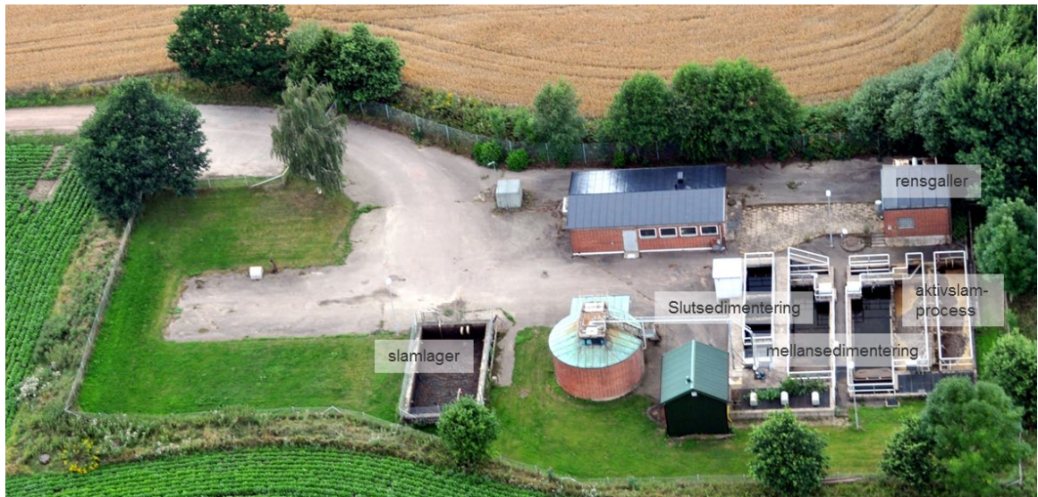
Figur 4. Foto över Kvidinge reningsverk som presenterar de olika reningsstegen.
