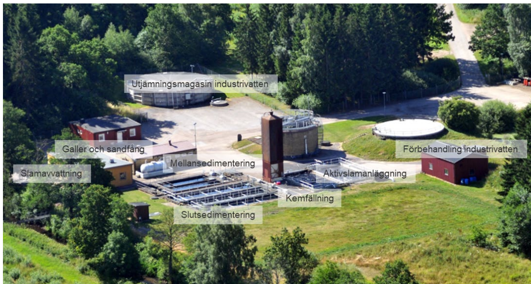
Figur 4. Flygfoto Kågeröd avloppsreningsverk och de olika anläggningsdelarna.
