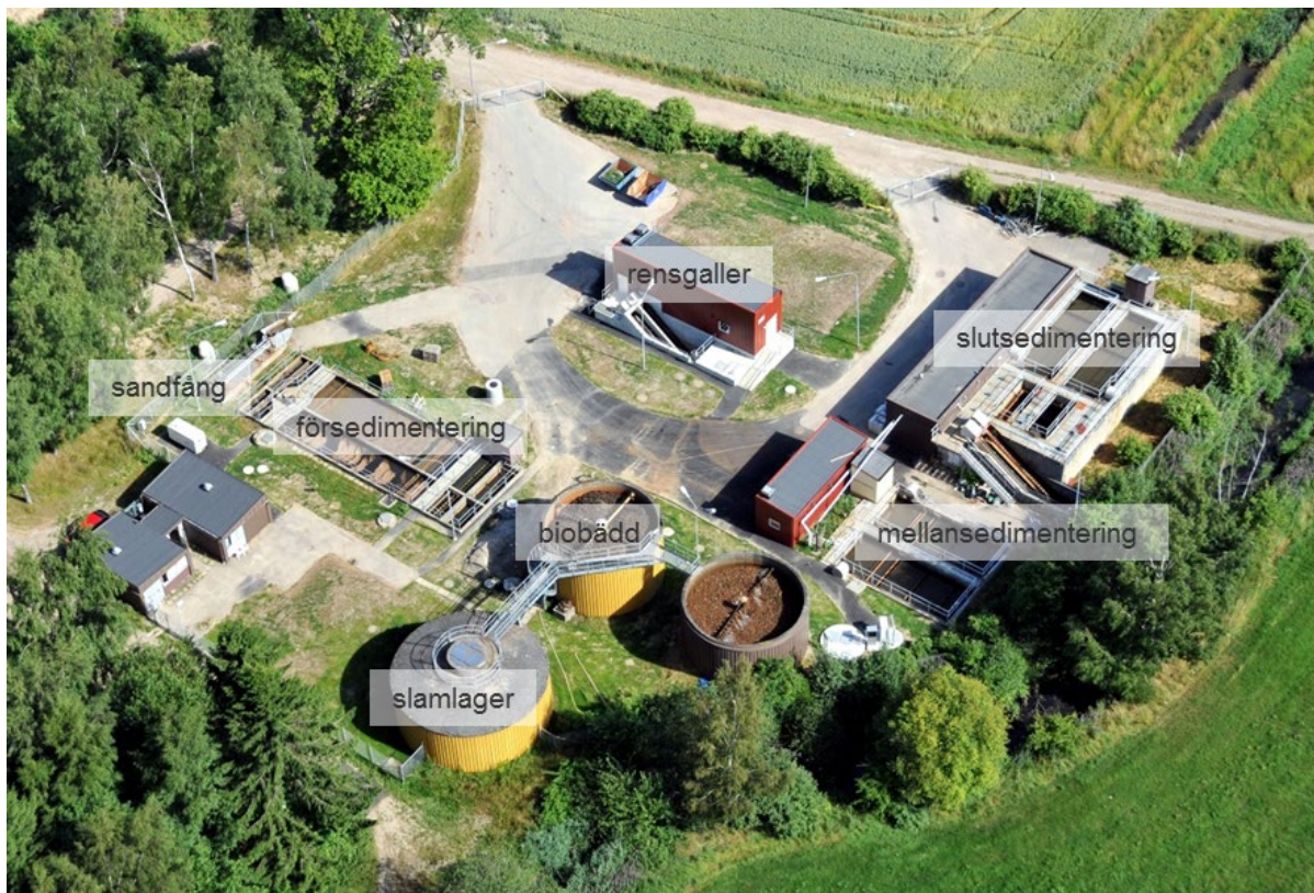
Figur 4. Flygfoto Ekeby avloppsreningsverk och de olika anläggningsdelarna.
