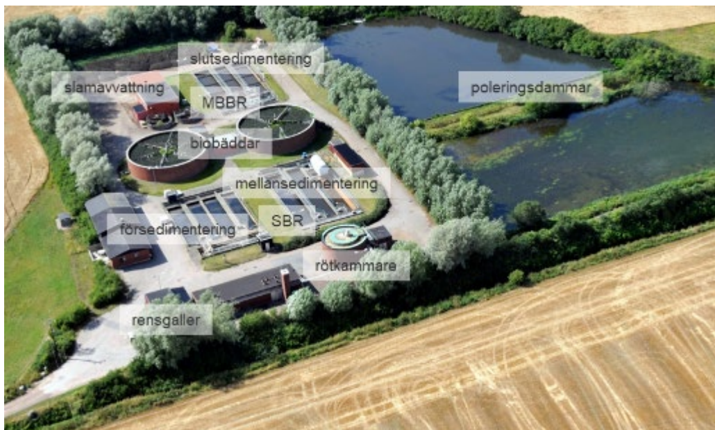
Figur 4. Flygfoto Ekebro avloppsreningsverk och de olika anläggningsdelarna
