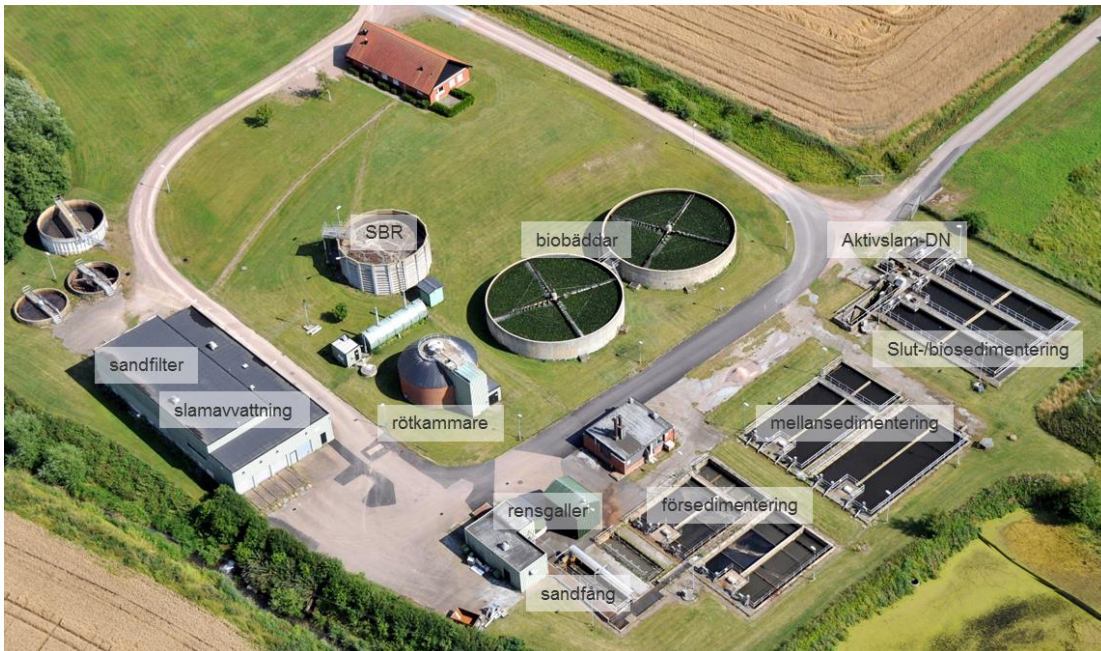
Figur 4. Foto över Nyvångsverket som presenterar de olika reningsstegen.
