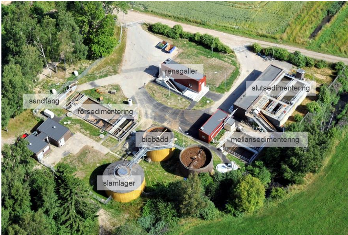
Figur 4. Flygfoto Ekeby avloppsreningsverk och de olika anläggningsdelarna.
