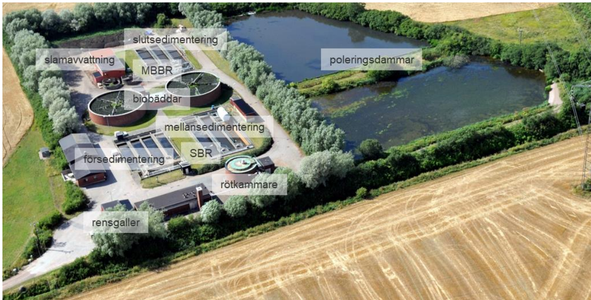
Figur 4. Flygfoto Ekebro avloppsreningsverk och de olika anläggningsdelarna.
