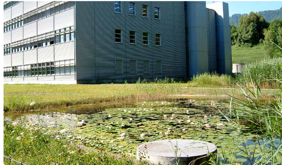
Dagvattendamm vid en industribyggnad i Zürich.
