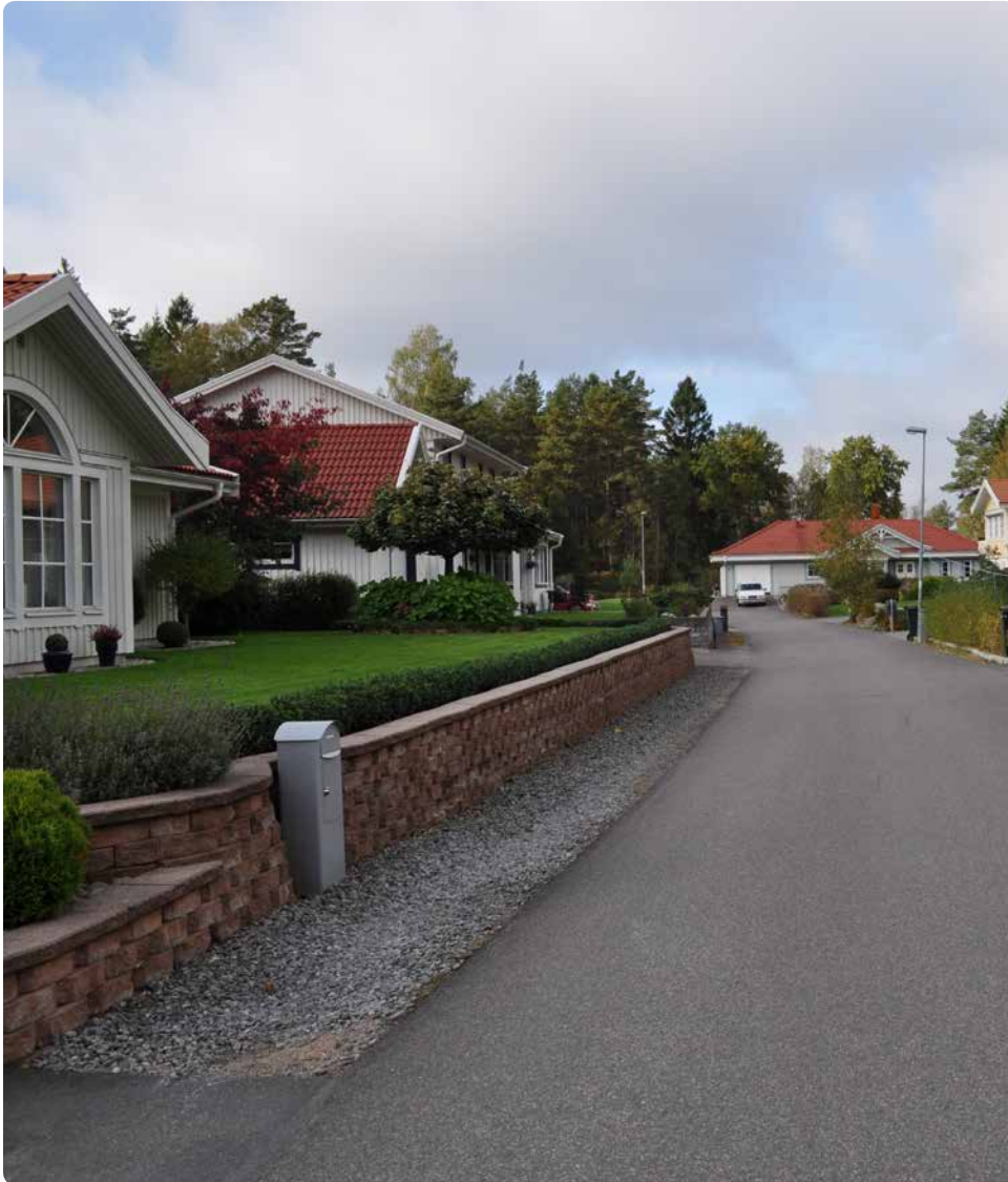
Makadamstråk längs gatan i ett villaområde i Mölnlycke. Stråket fördröjer både fastigheternas och gatans dagvatten. Dagvatten fördröjs dessutom i magasin på varje fastighet.
