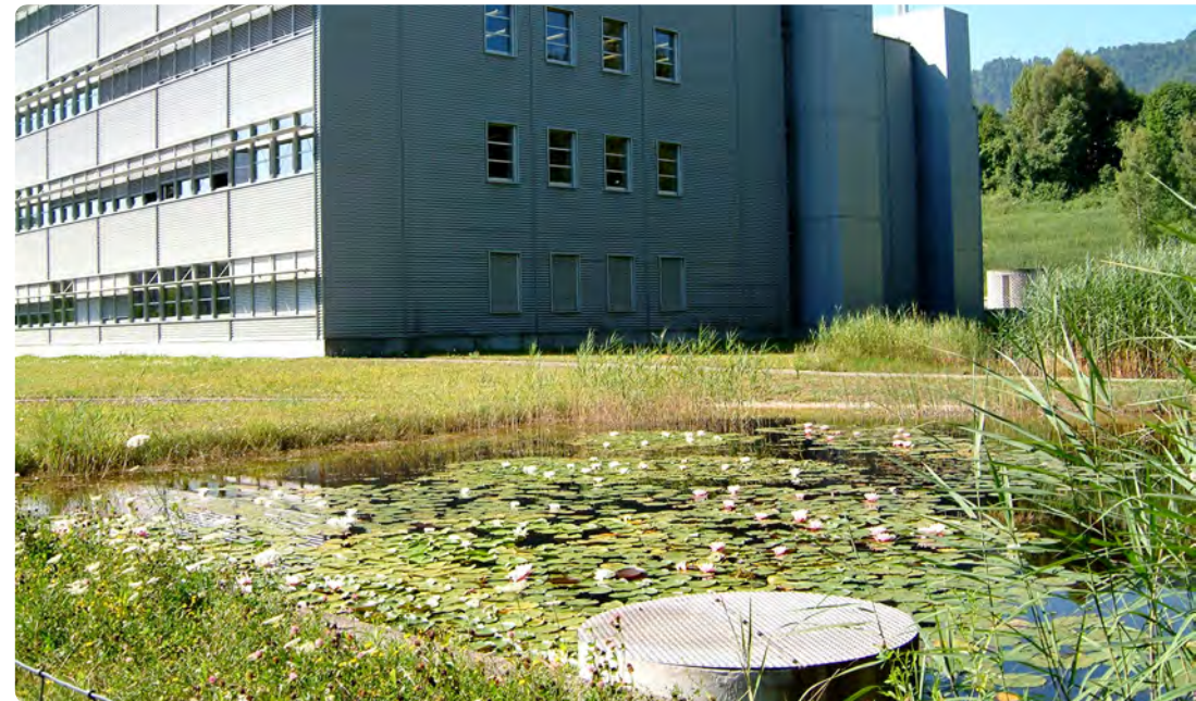
Dagvattendamm vid en industribyggnad i Zürich.
