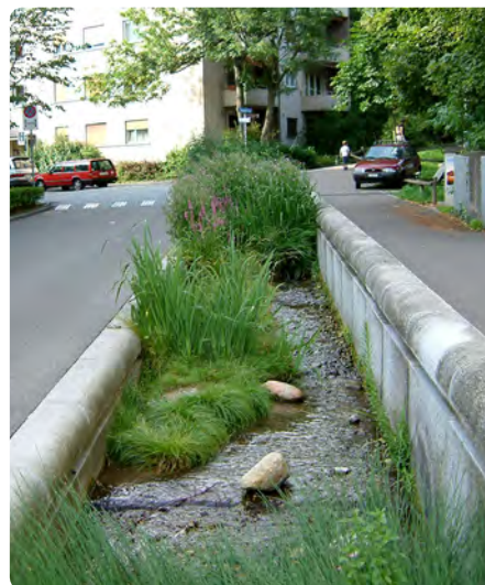
Vägdagvattnet kan också renas och fördröjas i en kanal, som vid denna gata i Zürich.
