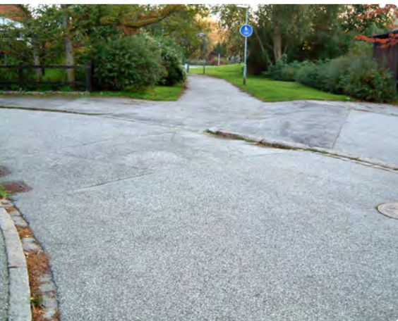
Gång- och cykelvägen har sänkts för att skapa en sekundär avrinningsväg för dagvattnet.
