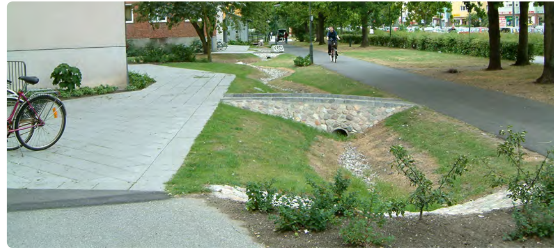
Trög avledning, svackdiken, har anlagts i ett befintligt bostadsområde i Augustenborg, Malmö.
