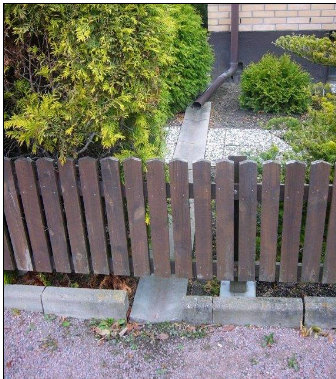
Figur 8 – exempel på hur dagvatten från ett stuprör i Hyllingelyckan leds ut på gatan via en ränna.
