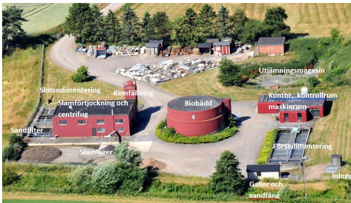
Figur 5. Foto över Svalöv reningsverk som presenterar de olika reningsstegen.
