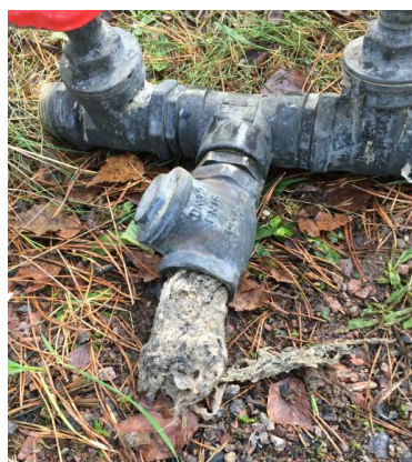
Figur 11. Våtservetter som sätter igen pumpar i pumpstationer
