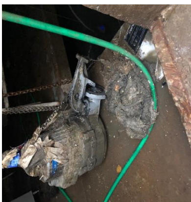
Figur 11. Våtservetter som sätter igen pumpar i pumpstationer
