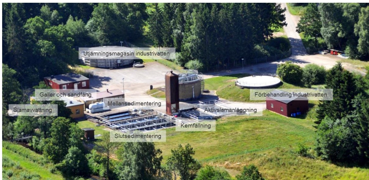
Figur 4. Flygfoto Kågeröd avloppsreningsverk.
