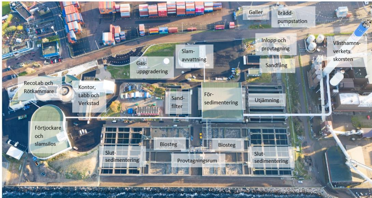
Figur 4. Foto över Öresundsverket och dess olika reningssteg.
