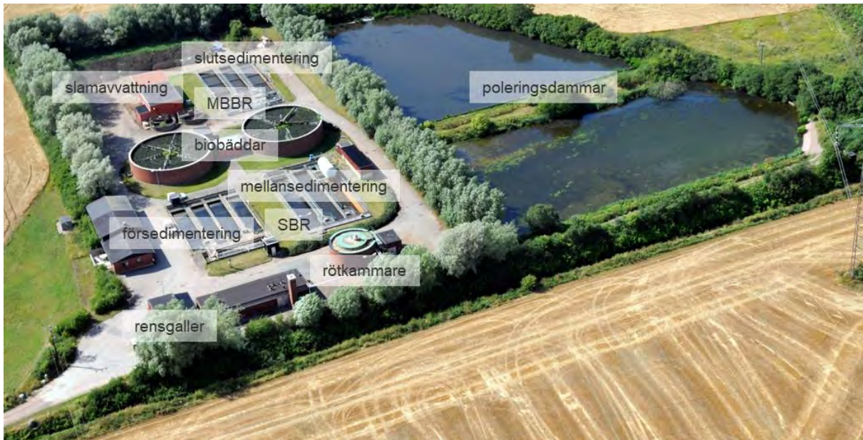
Figur 4. Flygfoto Ekebro avloppsreningsverk.
