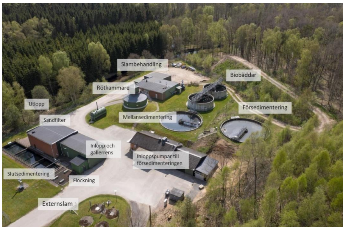
Figur 4. Foto över Örkelljunga avloppsreningsverk och de olika anläggningsdelarna
